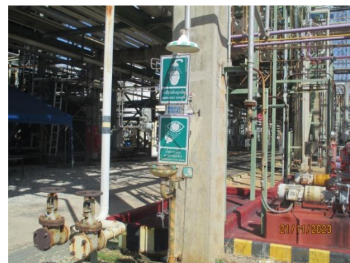
ภาพที่ 3-42 ฝักบัวฉุกเฉิน และที่ล้างตา
