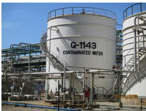
ภาพที่ 3-7 Contaminated Water Surge Tank (Q-1143)
