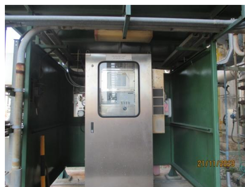
ภาพที่ 3-5 อุปกรณ์ตรวจวัดมลพิษอัตโนมัติแบบต่อเนื่อง (CEMs)
