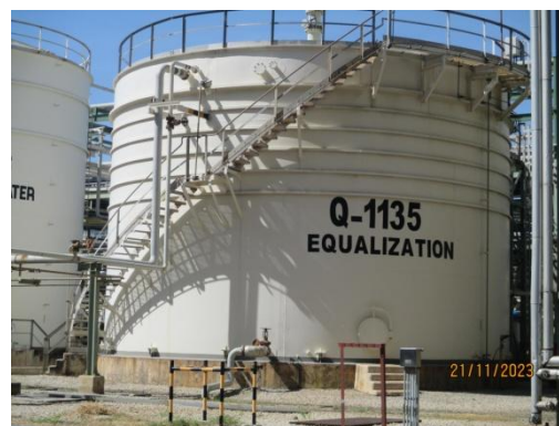
ภาพที่ 3-8 Equalization (Q-1135)
